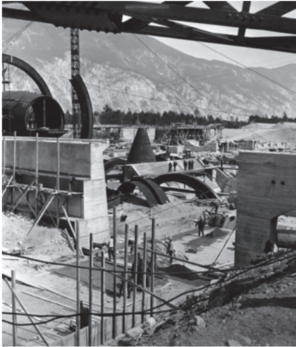
יסודות המתקנים של מנהרות הרוח בעמק אץ (Ötztal) באלפים האוסטריים בבנייה - 1943 מקור: DLR – Archiv Göttingen
